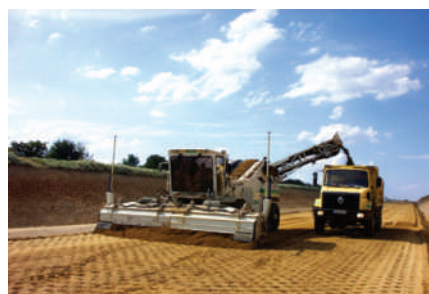
Figure 9 – Rotograde effectuant le réglage d'une couche de forme (Photothèque GTM Construction)
